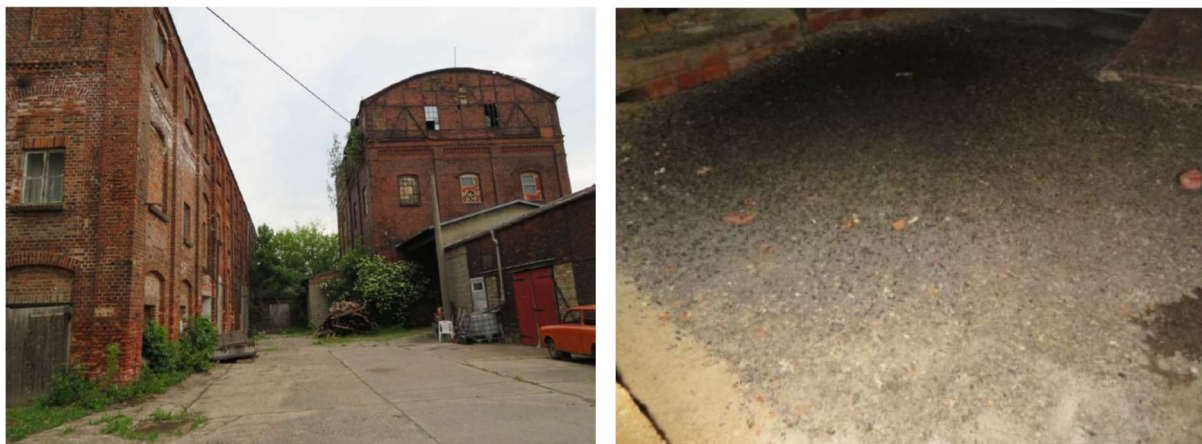
Abbildung 20: ehemaliges Schachtgebäude (li) und Fledermauskot unter dem Hangplatz im Gebäude (re)
